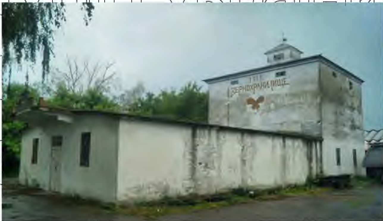
Рис. 2.5 - Зернохранилище, збудоване у 1913 році
