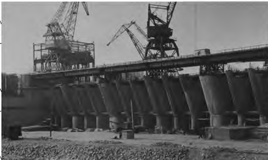
1955 год. Вид на здание ГЭС с верхнего бьефа.
