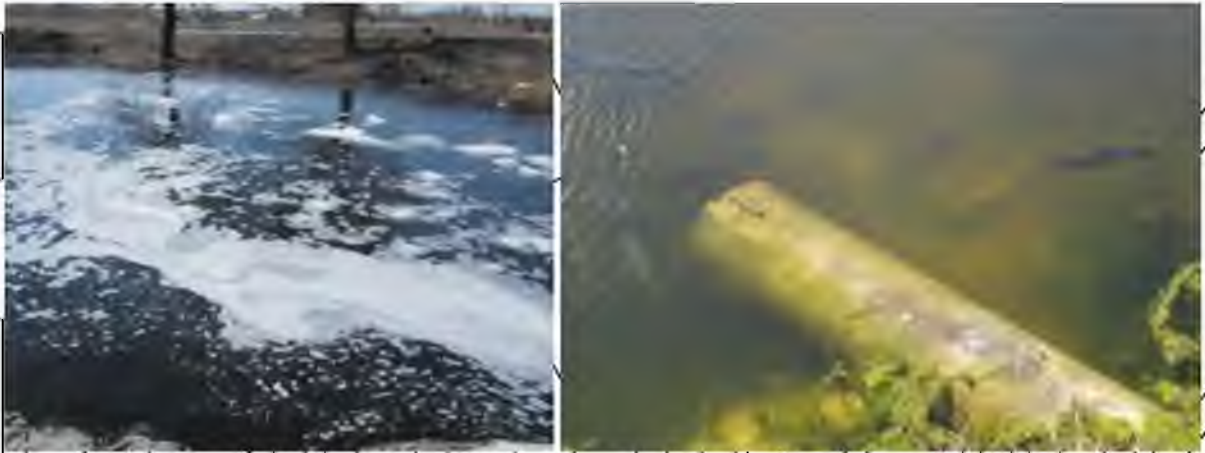
Рис. 2.2. Водовідвідний канал та водопостачальний трубопровід
