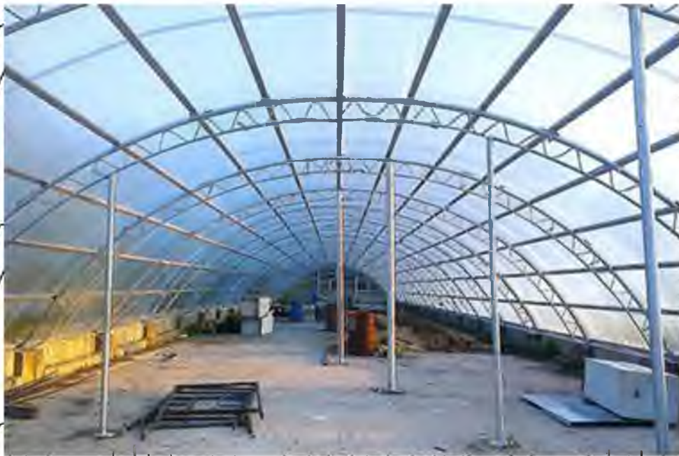
Рис. 3.2. Ангар з сотового полікарбонату – місце для розміщення УЗВ
