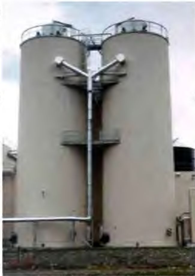
Рис. 2.1. Метантенки біогазової установки БГУ-100 [1]
