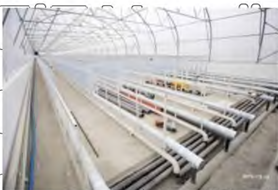
Рис. 1.6. Водяне опалення споруд закритого ґрунту
