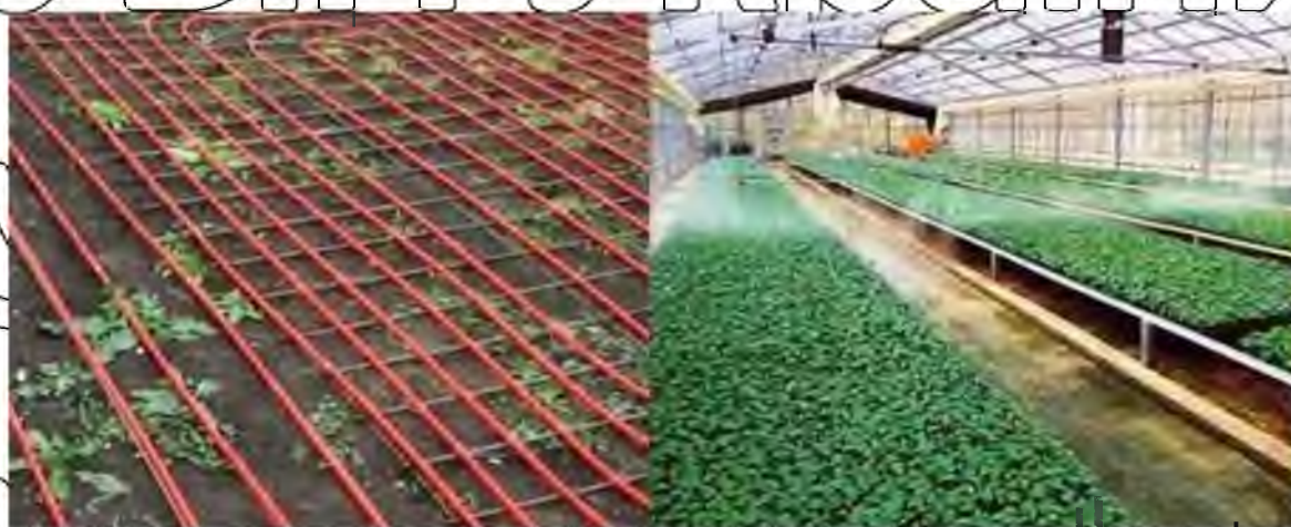
Рис. 1.8. Опалення теплиць з використанням нагрівального кабелю
