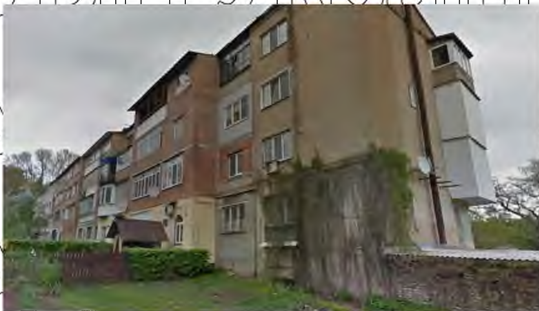
Рис. 2.1 – Загальний вигляд житлового будинку.
