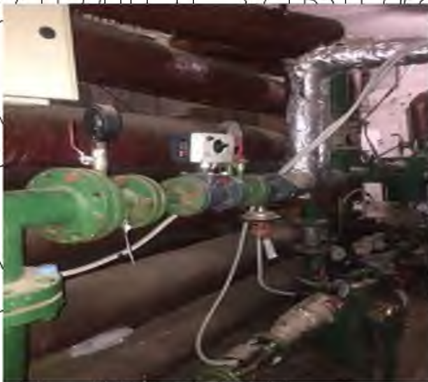
Рис. 2.5 – Поточний стан трубопроводу.
