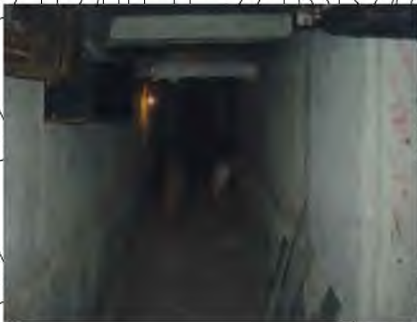
Рис. 2.5 – Поточний стан підвалу
