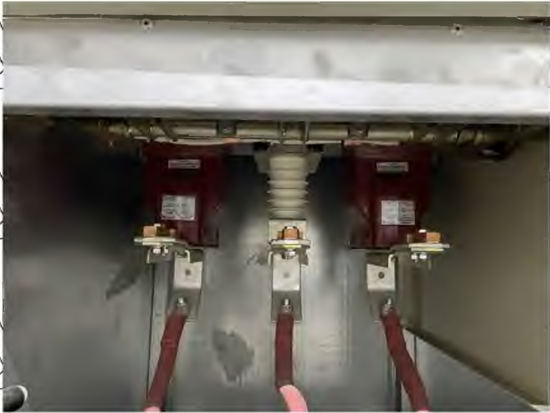
Рис. 1.8 Зовнішній вигляд трансформатора струму ТПЛ-10: Т – трансформатор струму; П – прохідний; Л – зливою ізоляцією; 10 – клас напруги, кВ.
