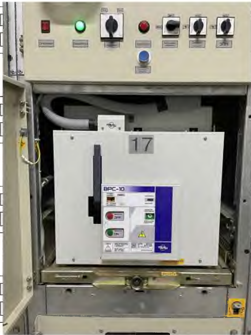
Рис. 1.5 Візок вимикача 10 кВ
