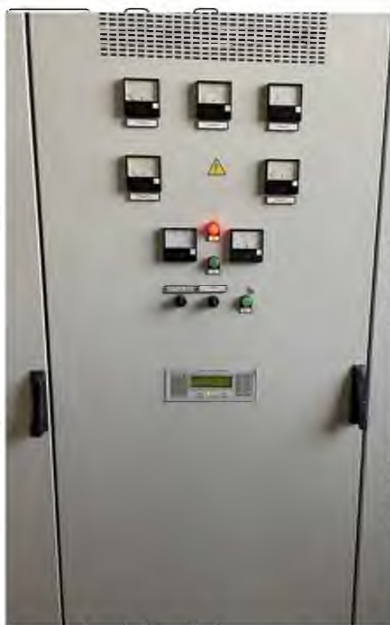
Рис. 1.9 Зовнішній вигляд ШОС
