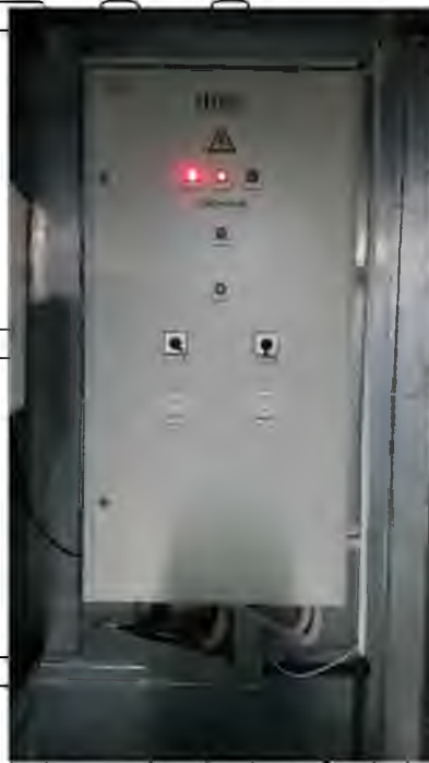
Рис. 1.10 Зовнішній вигляд шафи власних потреб
