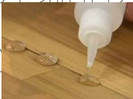
Рис. 1.15. Герметизація щілин
