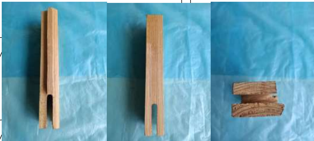
Рис. 3.1. Деталь дерев'яного вікна з вушком
