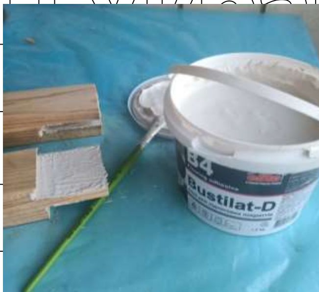
Рис. 3.11. Процес нанесення клею будівельного «БУСТИЛАТ Д»
