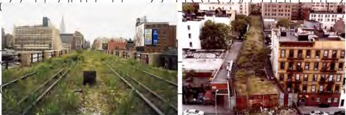
Рис. 3.7. Естакада High Line до того, як стала парком [53]
