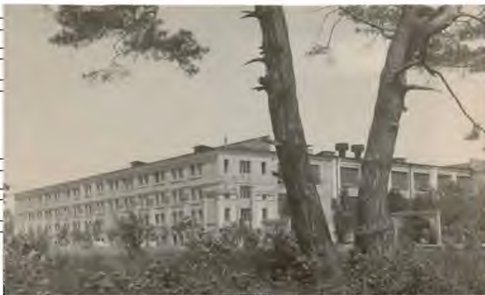
Рис. 2.3. Корпус фарбувального відділення 1950-ті [11]
