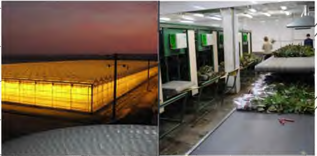
Рис. 2.10 Теплиці Камелії з сучасним обладнанням [9].
