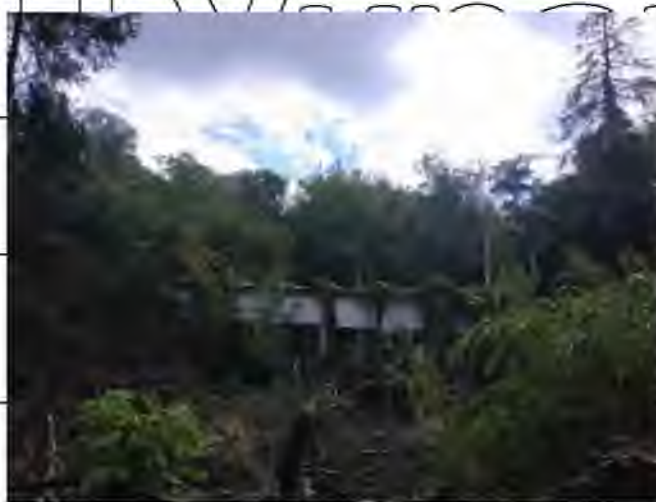
Рис. 3.10. Насосна станція (фото автора)
