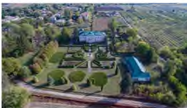
Рис. 2.3. Головний корпус Дослідної станції помології [29]
