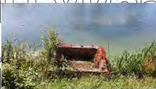
Рис. 3.4. Водоскид (фото автора)
