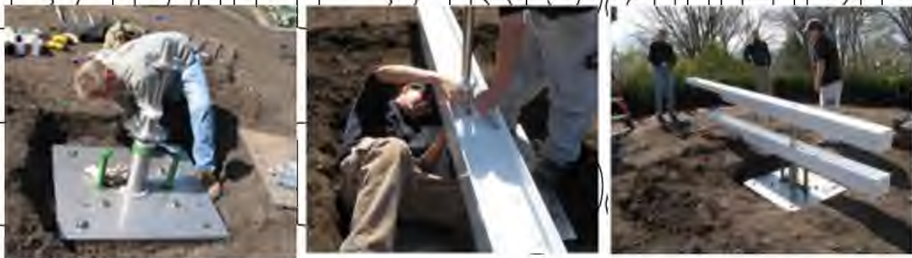
Рис. 4.9. Встановлення механізму та стрілок квітничкового годинника [11]
