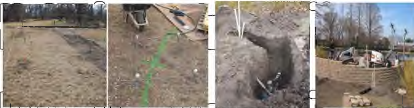
Рис. 4.5. Розмітка території, вирівнювання ґрунту, підведення поливу, будівництва основи
