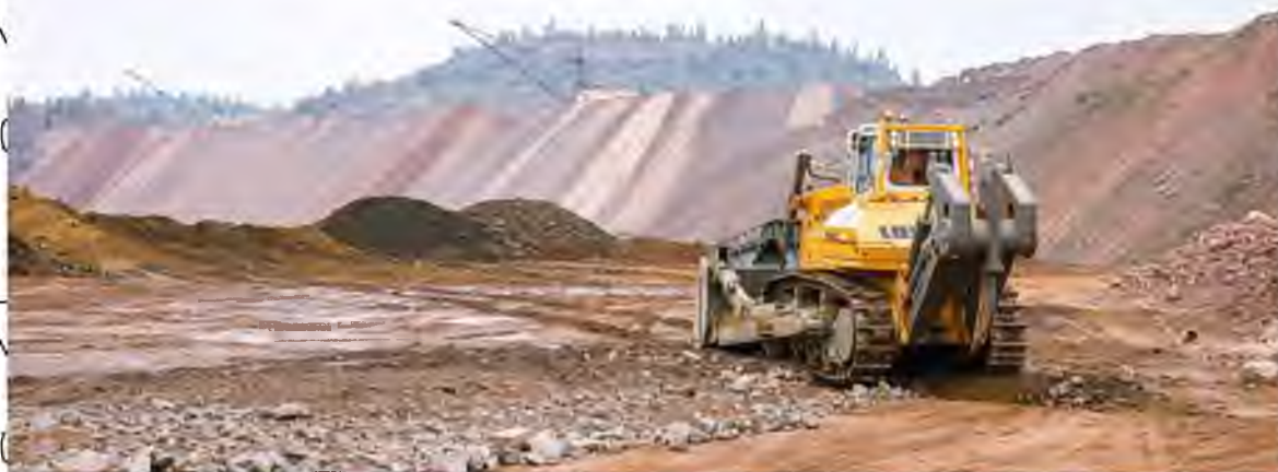
Рис. 1.5. Технічна рекультивация порушених земель
