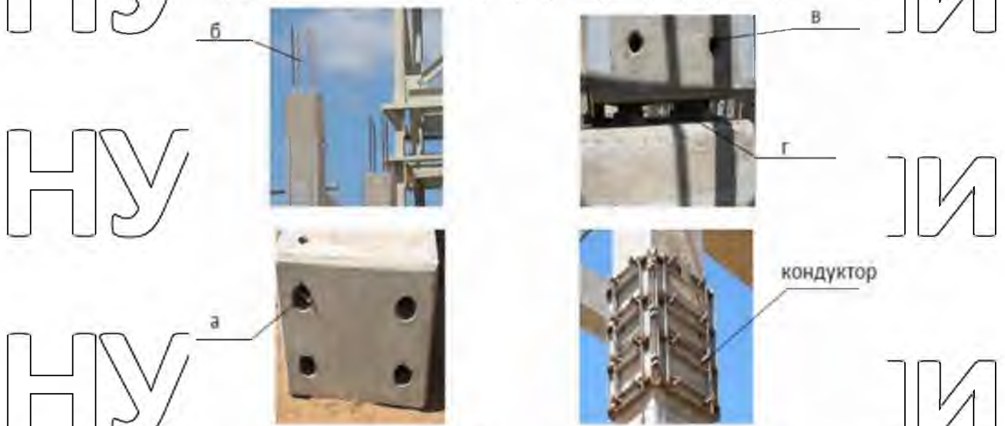
Рис. 1.2. Приклади штепсельних стиків з'єднання залізобетонних колон
