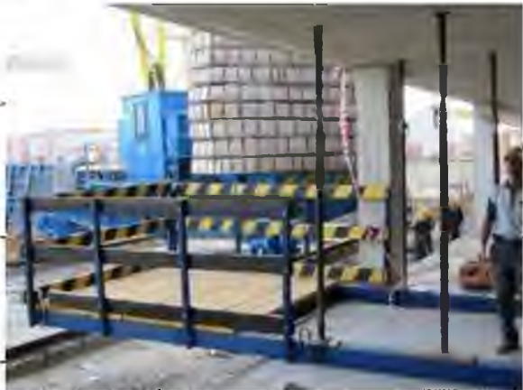
Монтаж виносної площадки.
