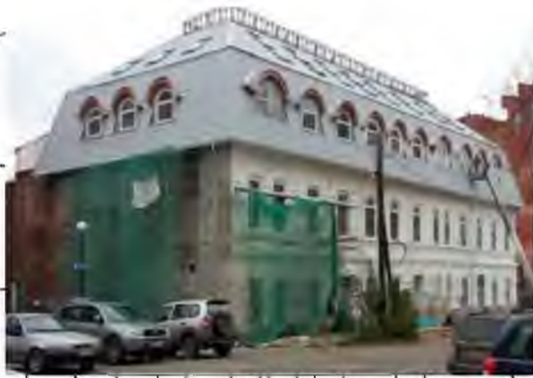
Рис. 1.7. Приклади виконання мансардних поверхів, які здійснені внаслідок проведення реконструкції цивільних будівель
