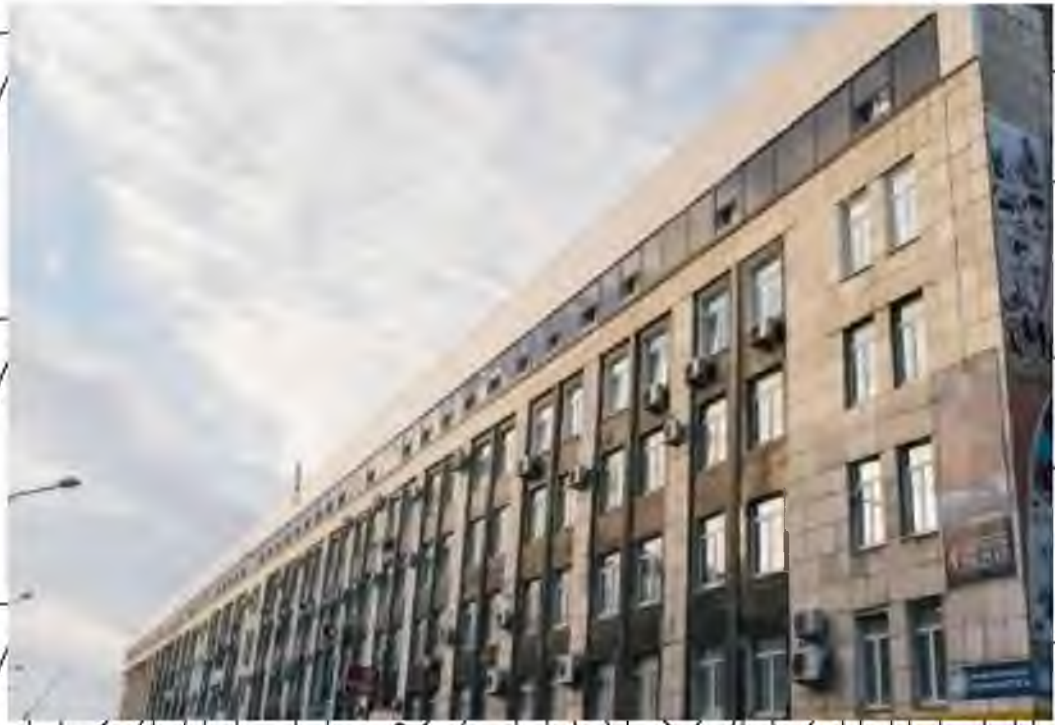
Рис. 1.6. Приклад виконаної надбудови аттикового поверху при реконструкції цивільних будівель
