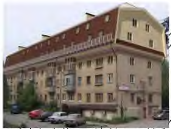
Рис. 1.7. Приклади виконання мансардних поверхів, які здійснені внаслідок проведення реконструкції цивільних будівель
