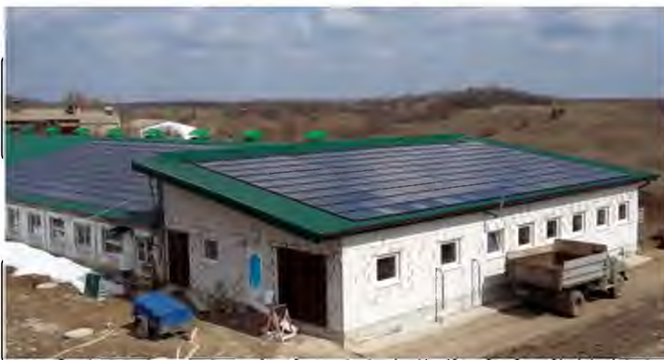
Рис. 1.2. Дахова BIPV сонячна електростанція «Вільховець»
