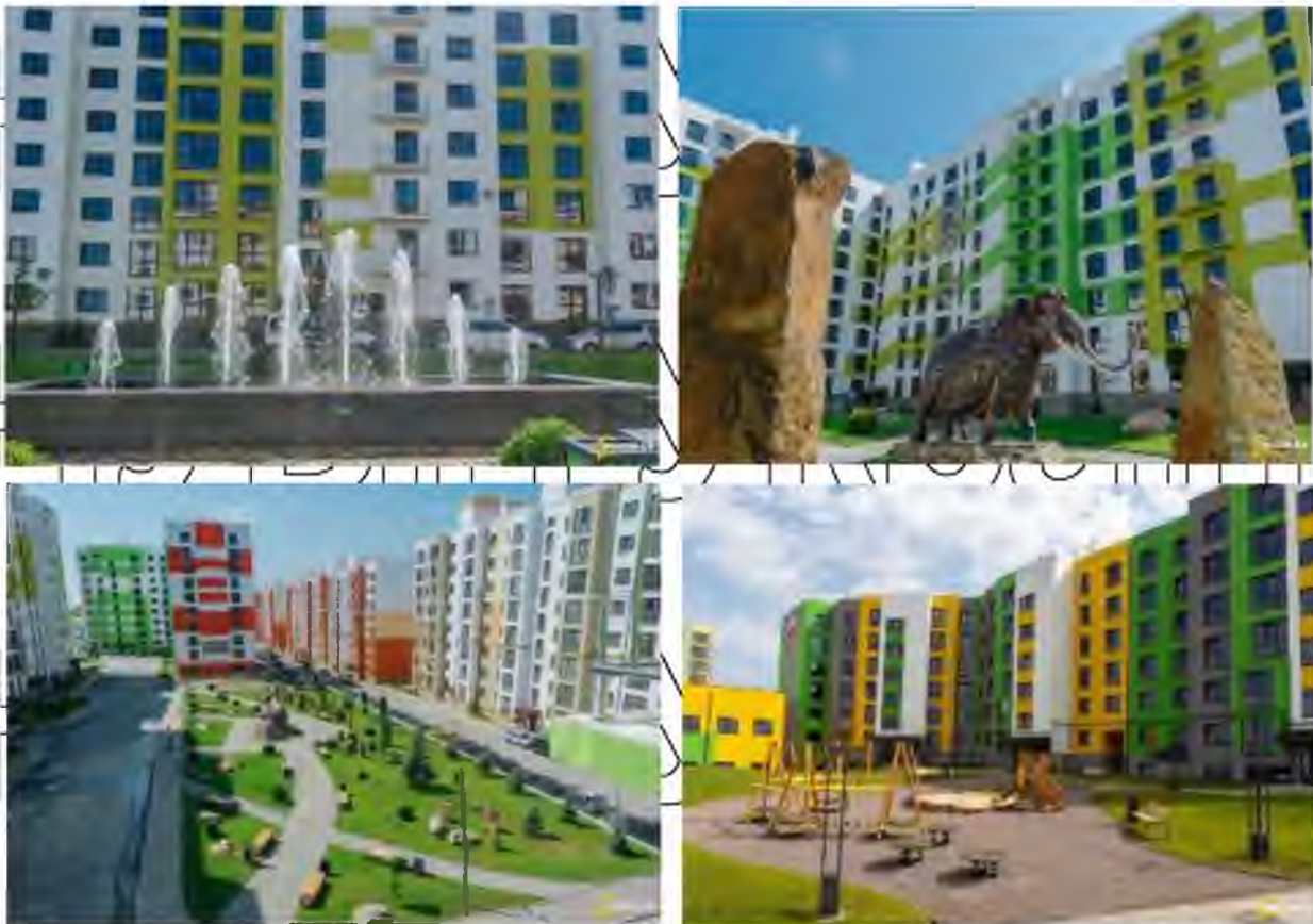
Рис. 1.7. Оздоблення внутрішньої закритої території житлового комплексу "На Щасливому", м Рівно
