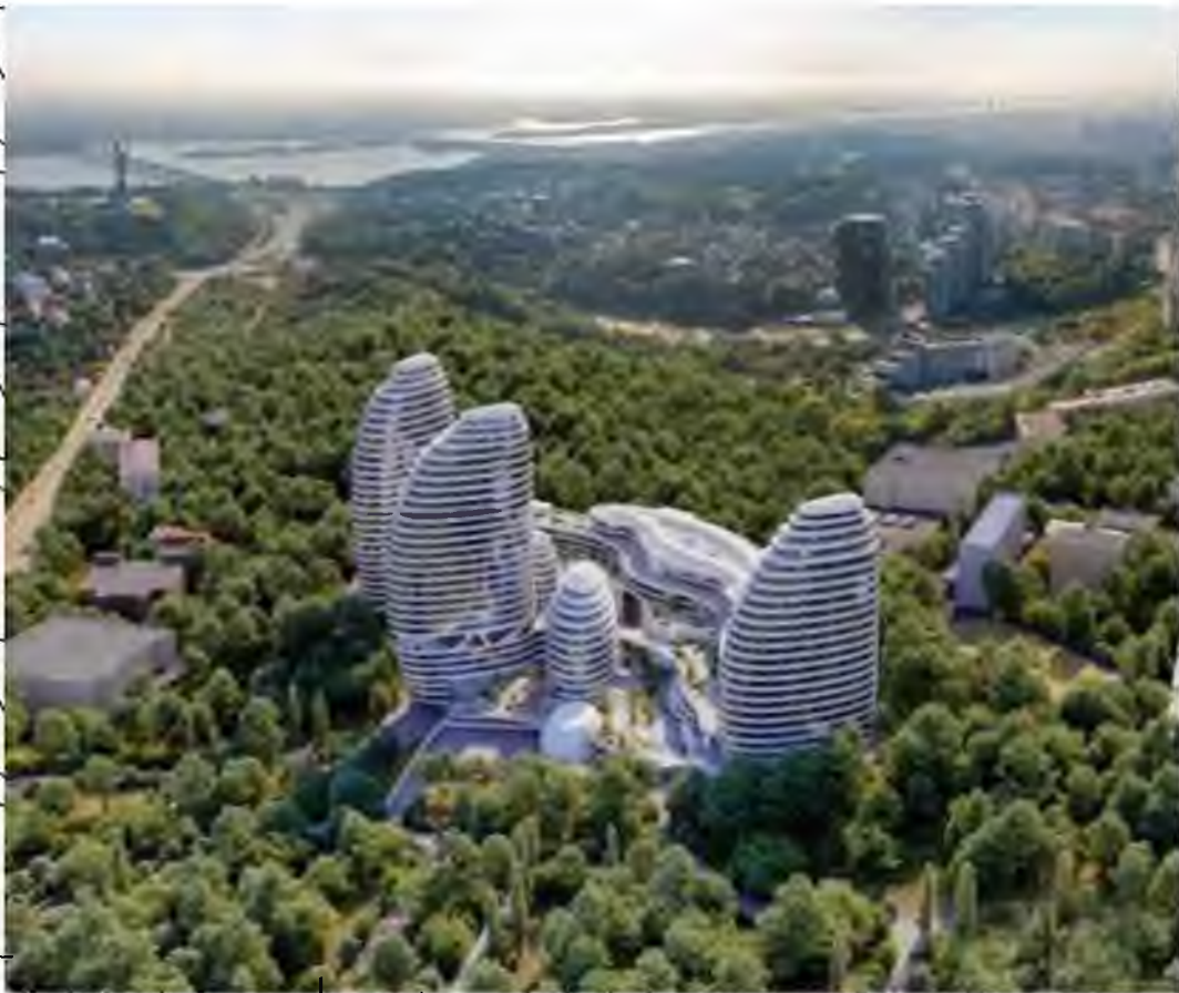
Рис. 1.9. Загальний вигляд житлового комплексу спроектованого Будівельною Компанією «Інтергал-Буд» в м. Києві, Печерський район, вул. Старонаводницька, 16 Б
