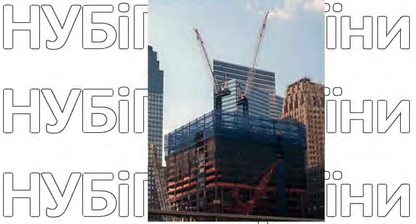
Рис. 1.1 – Самопідйомні крани на будівництві нового ВТЦ, Нью-Йорк
