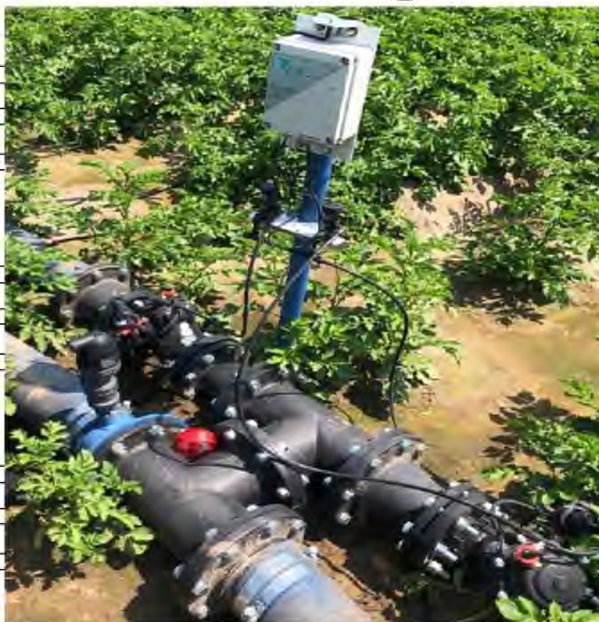
Рис. 2.8. Крановий вузол з регуляторами тиску і контролером
