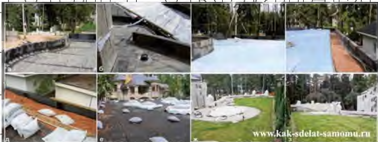
Рис. 3.8 Етапи встановлення покриття [20]
