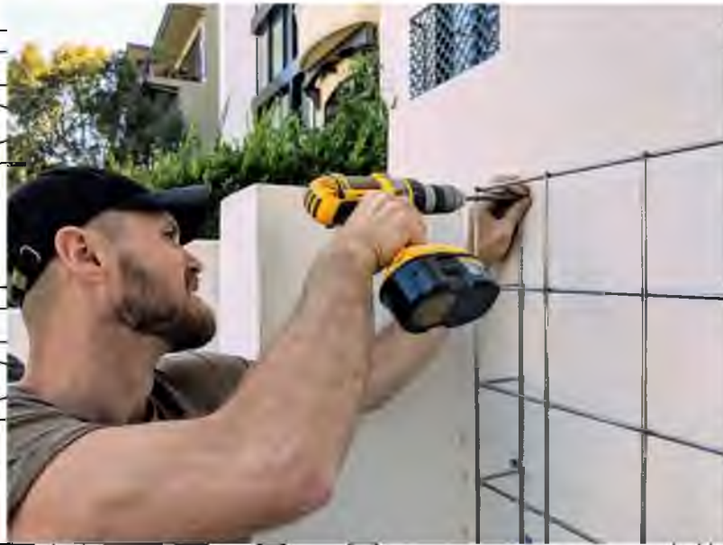
Рис. 3.6. Встановлення металевого каркасу [14]
