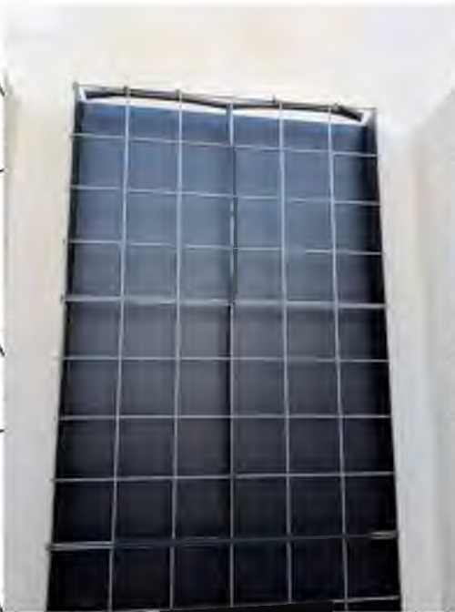
Рис. 3.7. Встановлення захисного екрану [14]
