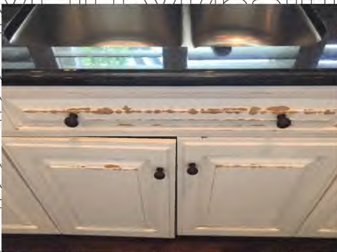
Рис. 1.12 Дефекти лакофарбового покриття, від впливу вологості [24]
