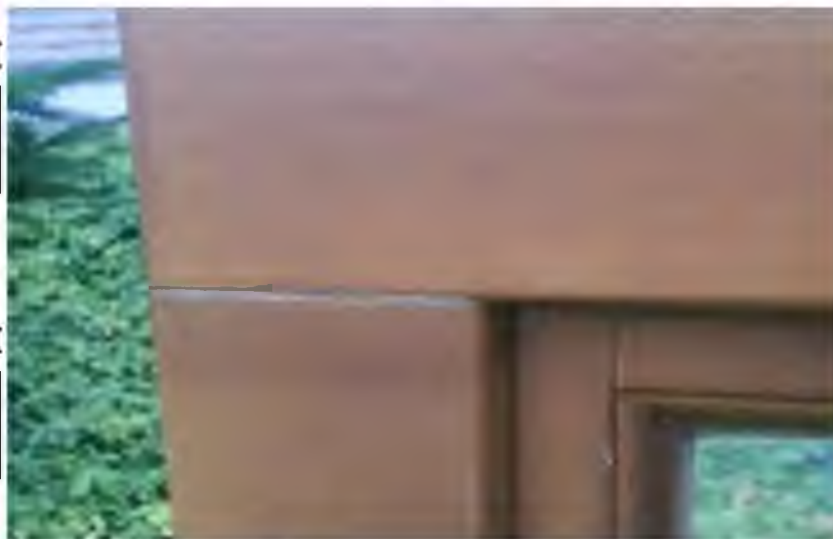
Рис. 3.4. Кутове віконне з'єднання в ацетильованому вікні [19]
