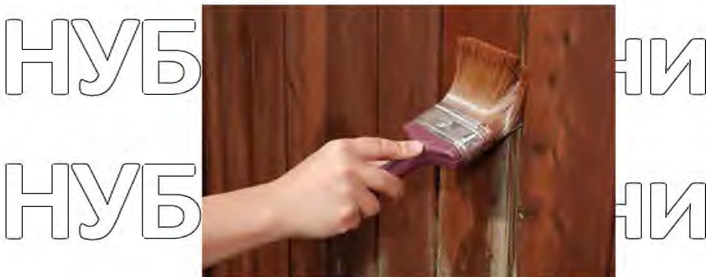
Рис. 1.9. Нанесення лакофарбового матеріалу пензлем [14]
