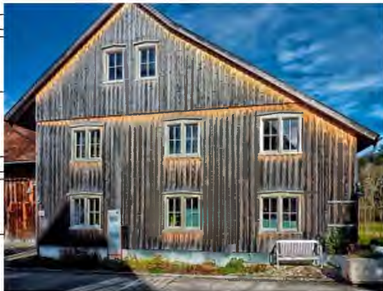
Рис. 1.3. Вигорання фасаду від прямих сонячних променів [10]
