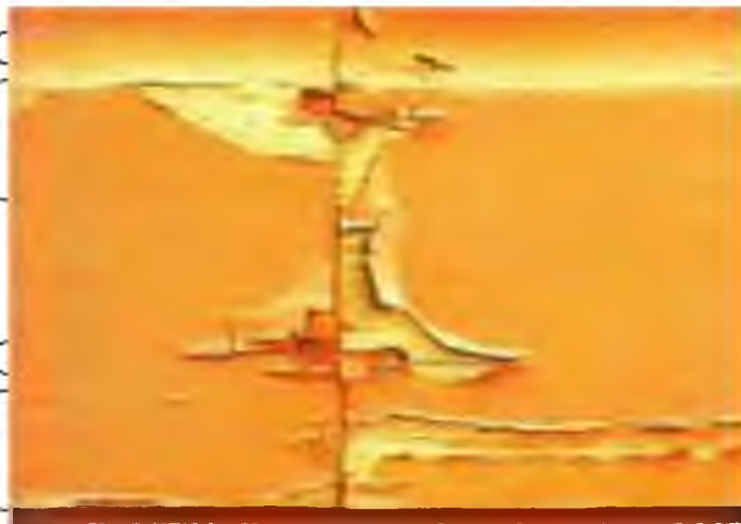
Рис. 1.7. Здуття і відшарування фарби [9]
