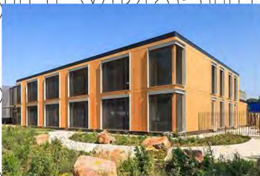
Рис. 3.3. Фасад з ацетилюваної деревини [19]
