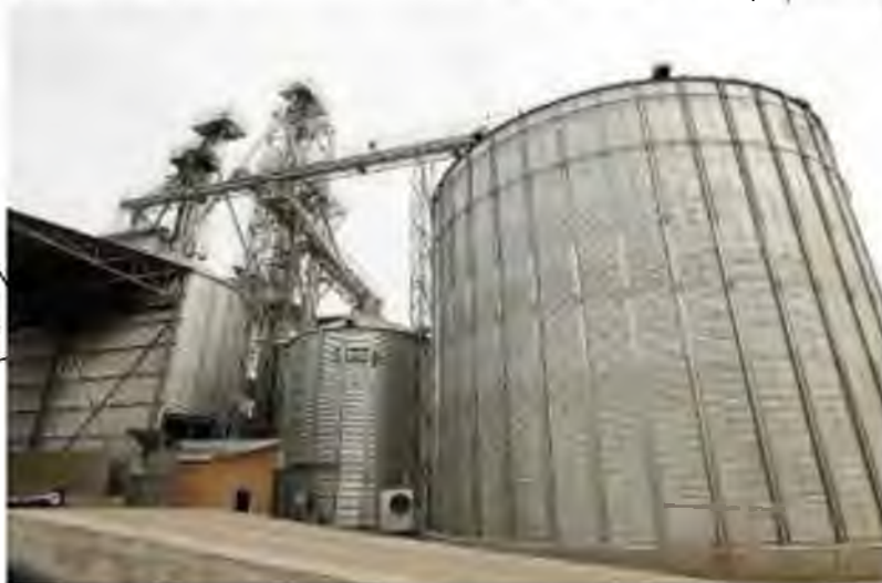
Рис. 2.2. Загальний вигляд елеватора «Імпульс»
