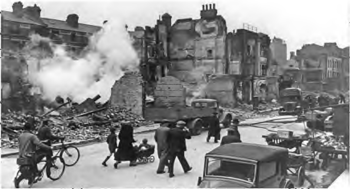
Рис. 1. Пішоходи проходять повз зруйновані бомбами будівлі в Лондоні, Англія. (Національний архів, Джерело: Constitutional Rights Foundation [15])
