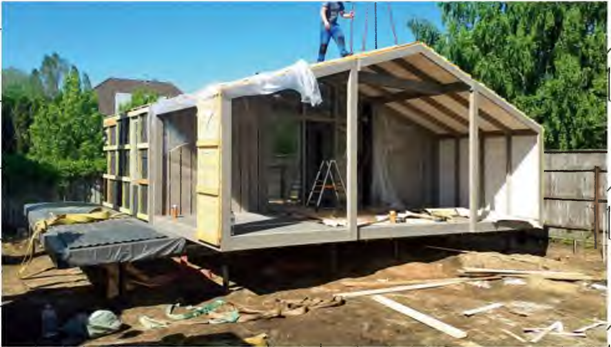
Рис. 14. Виготовлення модульного будинку. Джерело: ПМК-1 [20]
