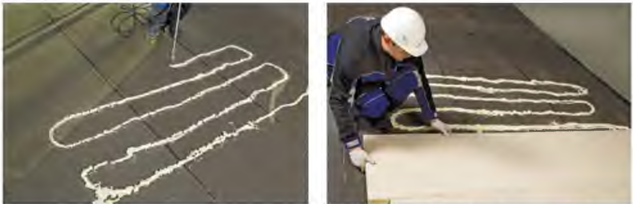
Рис. 3.4, 3.5 Нанесення клейового складу LOGICROOF SPRAY Adhesive Foam Склеювання PIR пластин
