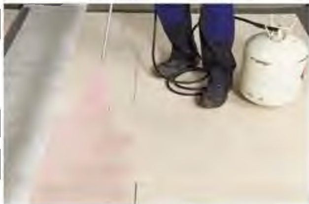
Рис. 3.15 Нанесення клейової композиції LOGICROOF Spray Contact adhesive
