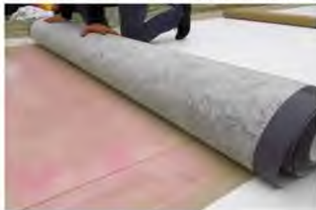
Рис. 3.15 Нанесення клейової композиції LOGICROOF Spray Contact adhesive
