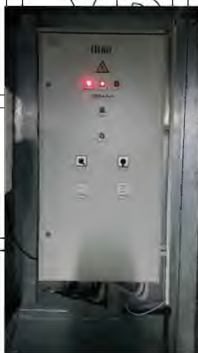
Рис. 1.16 Зовнішній вигляд шафа власних потреб
