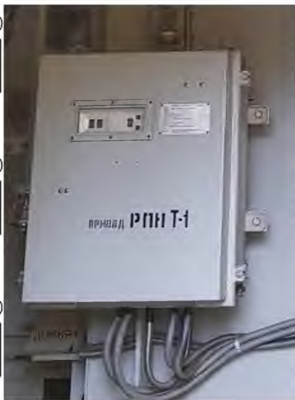
Рис. 1.6 Привід РПН силового трансформатора
