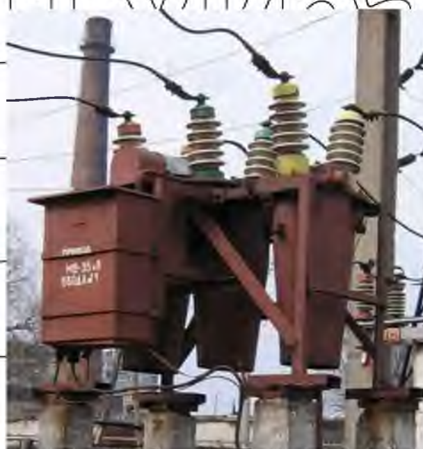
Рис. 1.4 Масляний вимикач серії ВТ-35А-630-12,5У(Т)1
