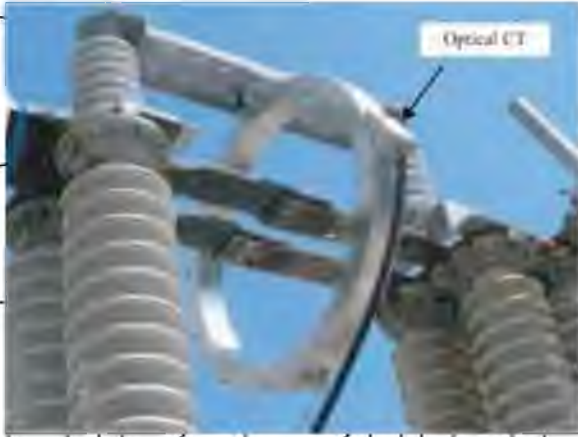
Рисунок 6 - приклади виконання ЦТС
