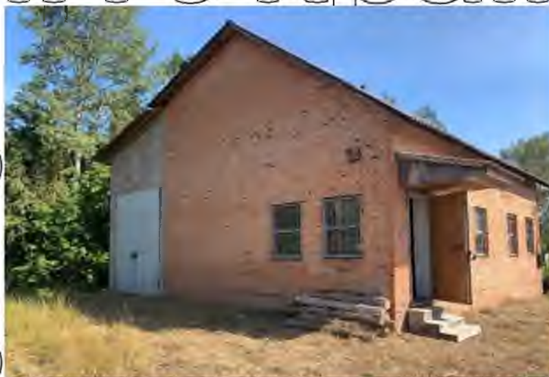
Рис. 5.1. Будівля шишкосушарки Воронізького лісництва
