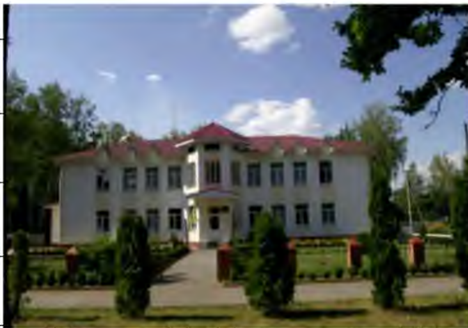
Рис. 3.1 Адміністративна будівля філії «Корюківське лісове господарство»
