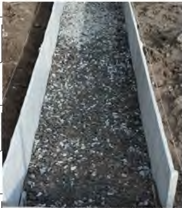
Рис. 2.1. Створення дренажного шару в коробах
