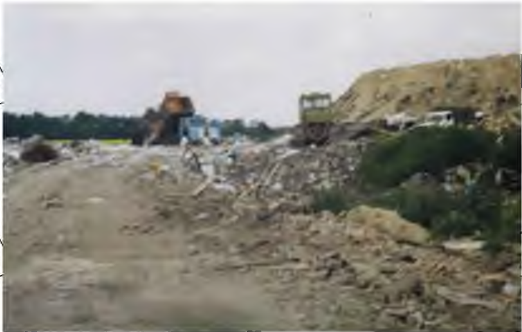
Рис. 3.15. Ущільнення бульдозером твердих побутових відходів на полігоні
