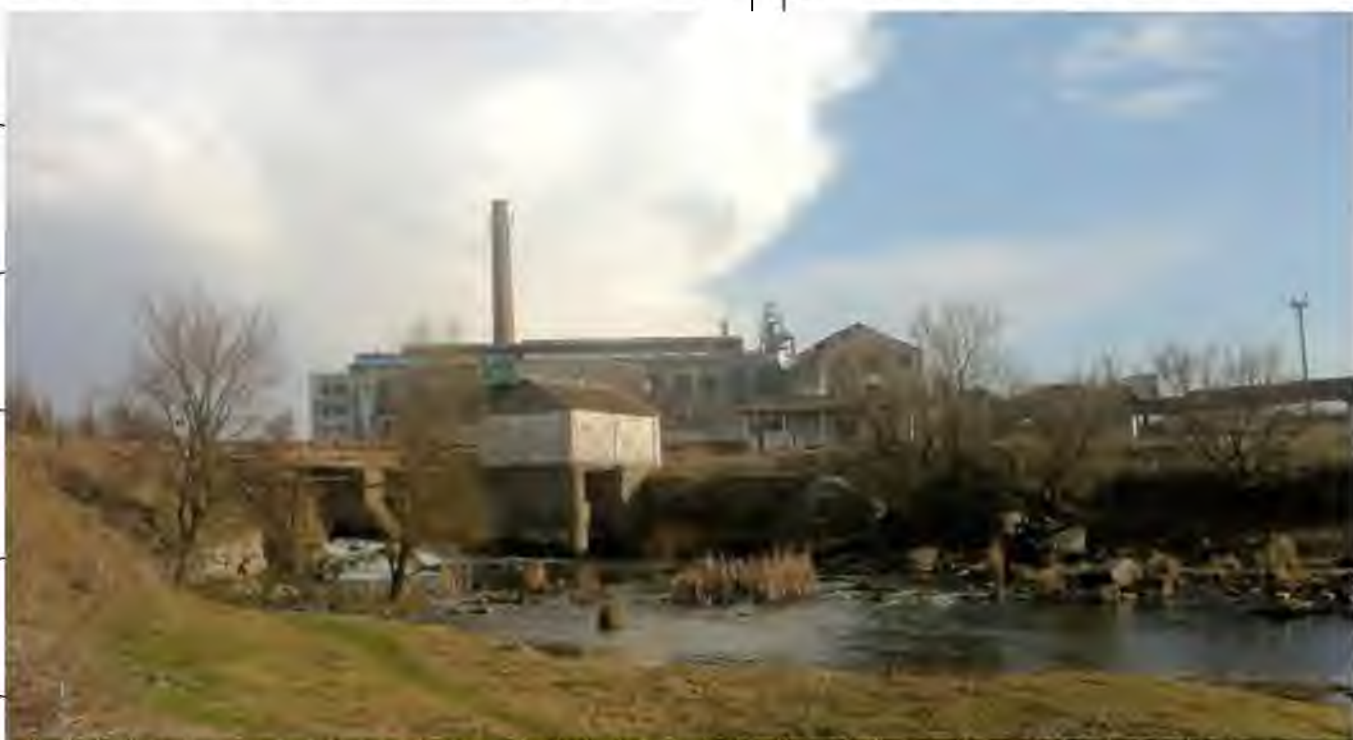
Рис.3.1. Гребля Турбівського водосховища на фоні цукрового заводу
