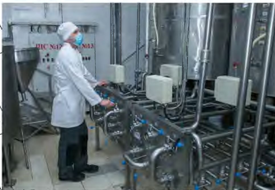
Рисунок 3.4. Процес прийому знежиреного молока в резервуар
