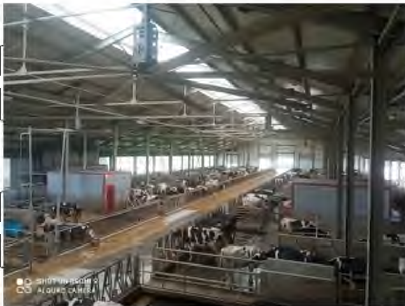
Рис. 2.3 Приміщення для утримання тварин
