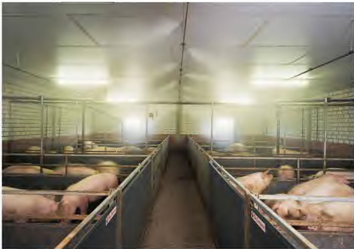
Рис. 1.4. Система висконапірного розпилення води CombiCool
