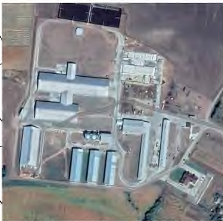
Рис.3.1.1. Загальний план розміщення виробничих об'єктів молочного комплексу для утримання 1000 корів в ПСП „Україна” Попільнянського району Житомирської обл.
