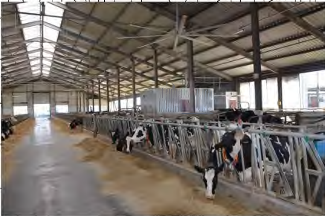
Рис.3.1.2. Система примусово- природньої вентиляції в приміщенні виробничої секції де утримують дійних корів (вид з боку кормового стола, обмеженого системою кед-локів).
