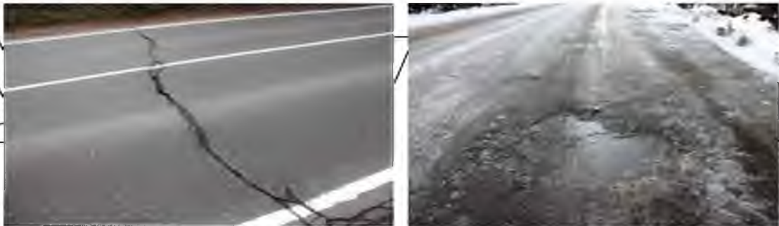
Рис. 3.8 Стан експериментального покриття у різні періоди року: а) при t = +10-15^{\circ}\text{C} ; б) при t = -10-0^{\circ}\text{C}
