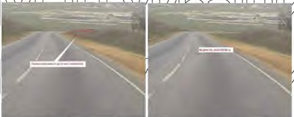
Рис. 3.8. Приклад невиявленої закритої видимості на дорозі II категорії при R=1000 м, з похилом 7‰
