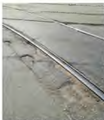
Рис. 3.30. Зовнішній вигляд ділянки трамвайного полотна
