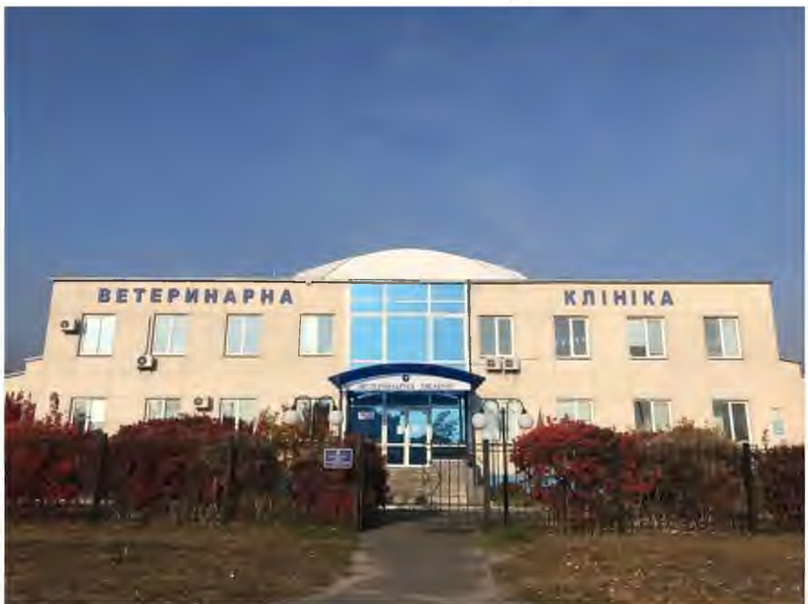
Рис.2.7. Основний корпус «КП Київська міська лікарня ветеринарної медицини» (м. Київ, вул. Електротехнічна 5А).
