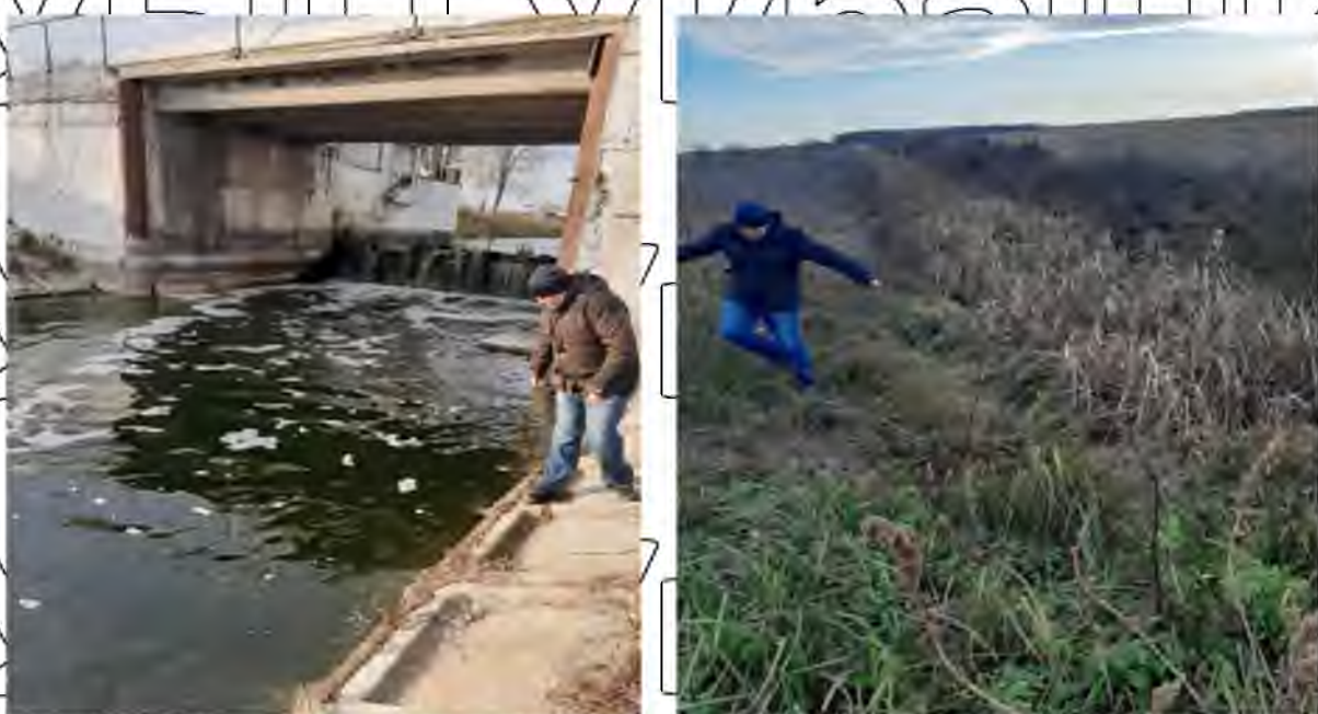
Рис. 3.2. Зношення гідротехнічних споруд і заростання чеків
