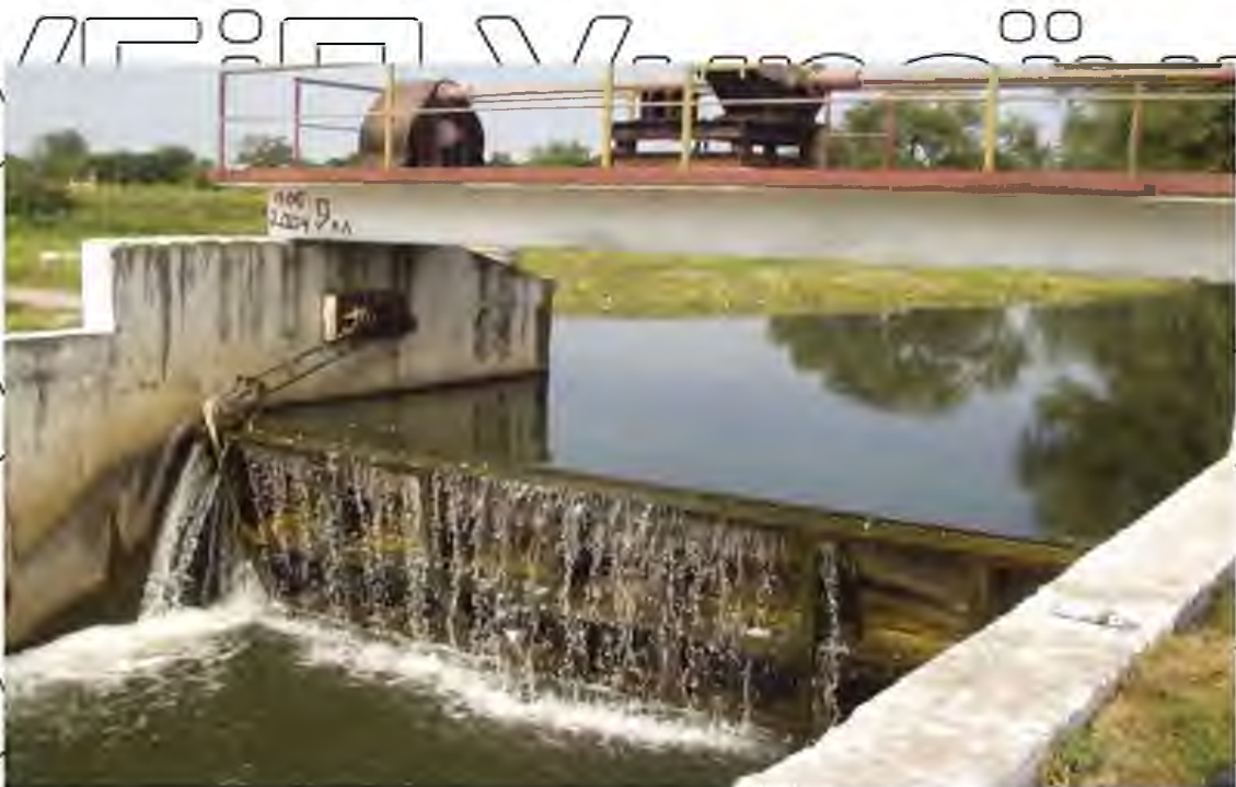
Рис. 2.2. Осушувально-зволожувальна система двосторонньої дії
