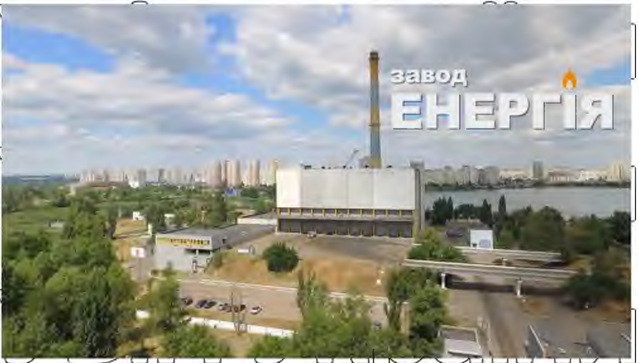
Рис 6. СП «Завод ЕНЕРГІЯ» КП «КИЇВТЕПЛОЕНЕРГО»
