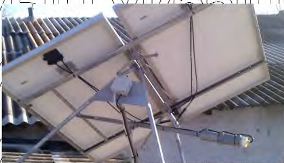
Рисунок 1.8 – Зображення сонячної панелі з встановленими актуаторами.
