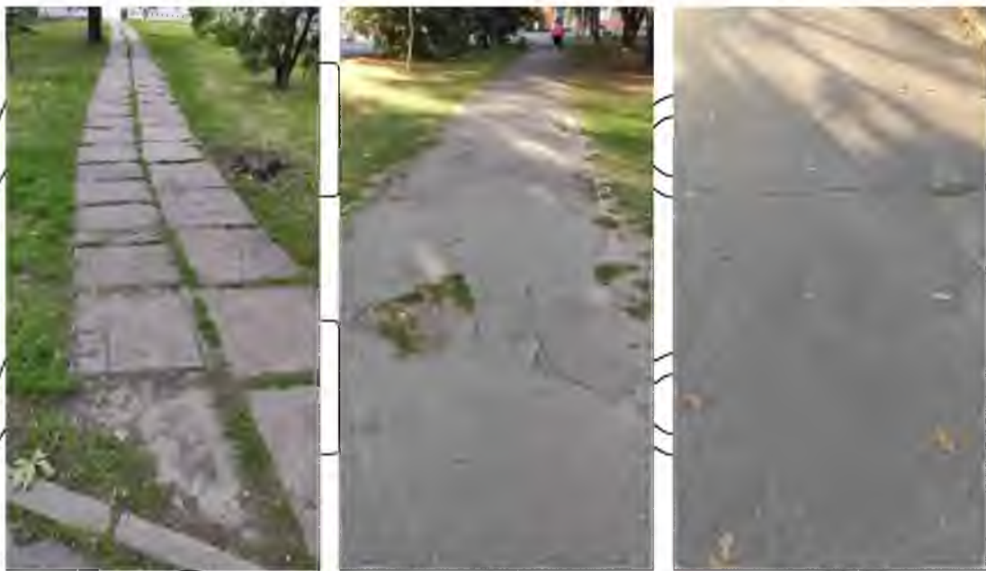
Рис. 3.12. Сучасний стан покриття другорядних доріжок на територіях скверів: а – «Героїв Небесної Сотні»; б – «ім. Тараса Шевченка»; в – «Тисячоліттю заснування міста» (фото автора)
