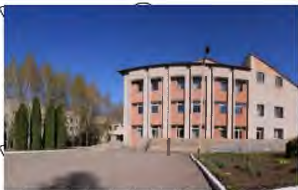
Рис. 1.38. КЗ "Хмельницька центральна районна лікарня" [38]
