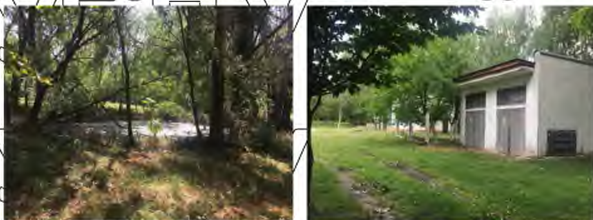
Рис. 3.16. Водойма та будівлі КП «Березневодоканал» на території центрального міського скверу в м. Березне Рівненської області (фото автора, 2021 рік)
