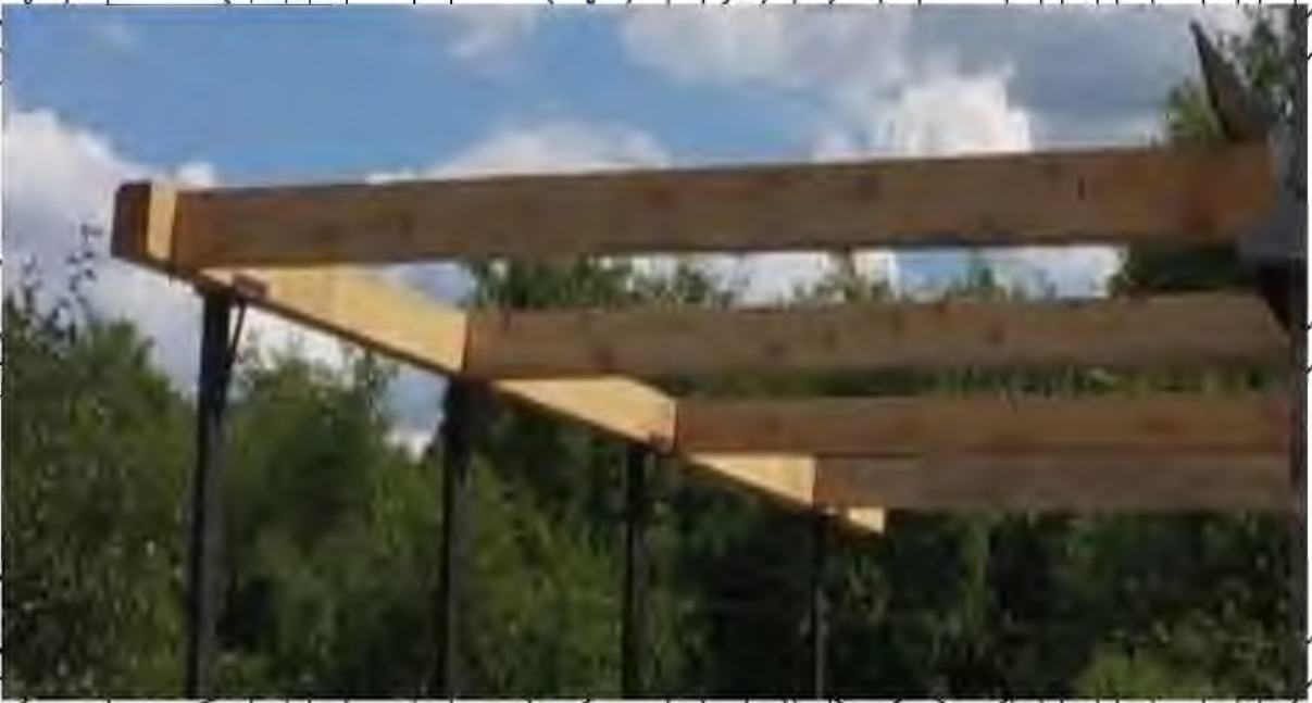
Рис 4.6 Бруси для укріплення конструкції
