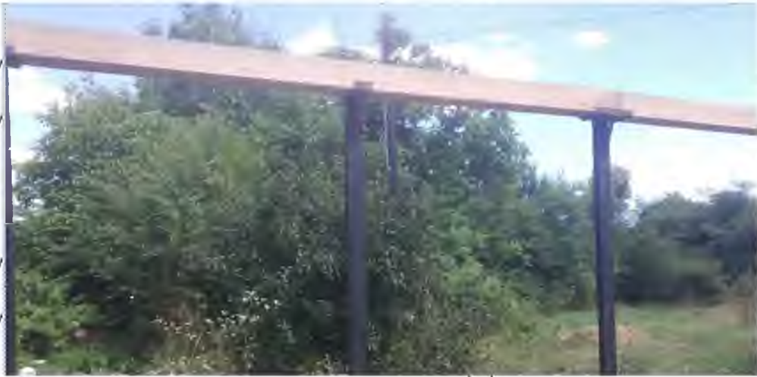
Рис 4.4. Мауерлат на металевих профілях
