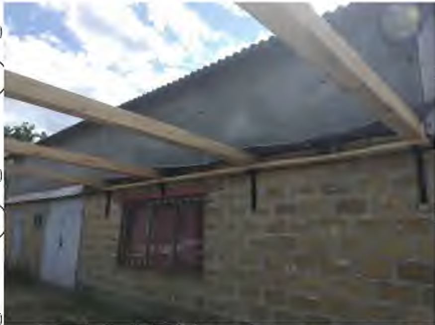
Рис 4.5 Встановлення опорних балок
