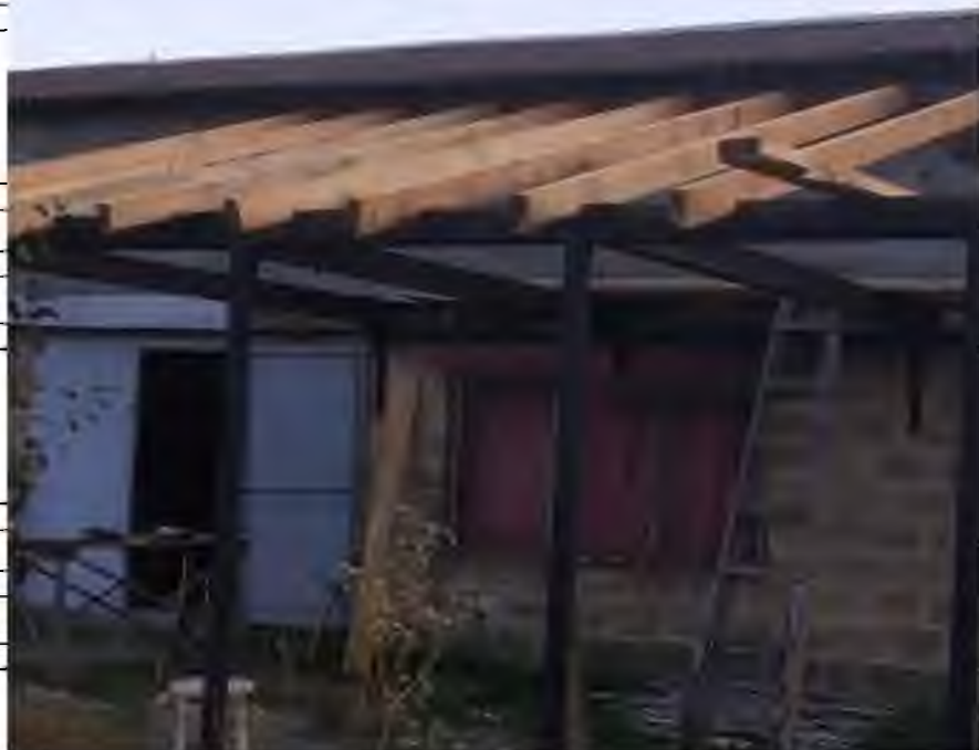
Рис 4.8. Встановлення крокв
